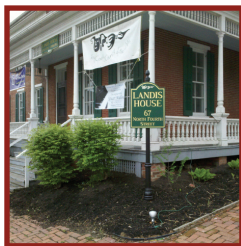
Landis House 67 N. Fourth St., Newport
